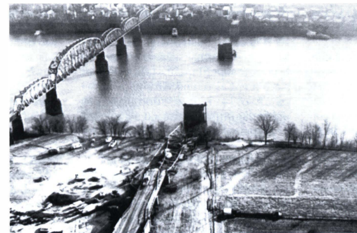
Point Pleasant: il nuovo ponte e i piloni rimasti dopo il crollo del 1967
